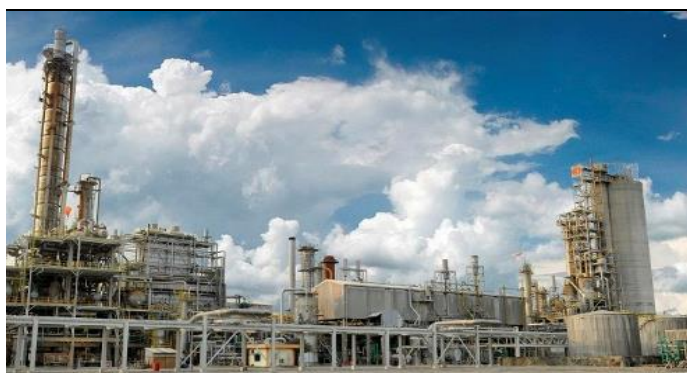
PKT-3 plant of Pupuk Kaltim
